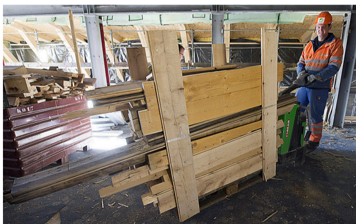
Logistisch anspruchsvoll ist der Transport des Abbruchmaterials. Es muss verkleinert und in Minimulden an den Touristenströmen vorbei nach Grindelwald gebracht werden.
