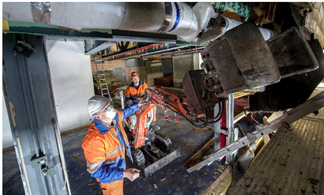
Die Isolation muss weg, der Dachablauf bleibt. Die Abbrucharbeiter gehen zentimetergenau vor.
