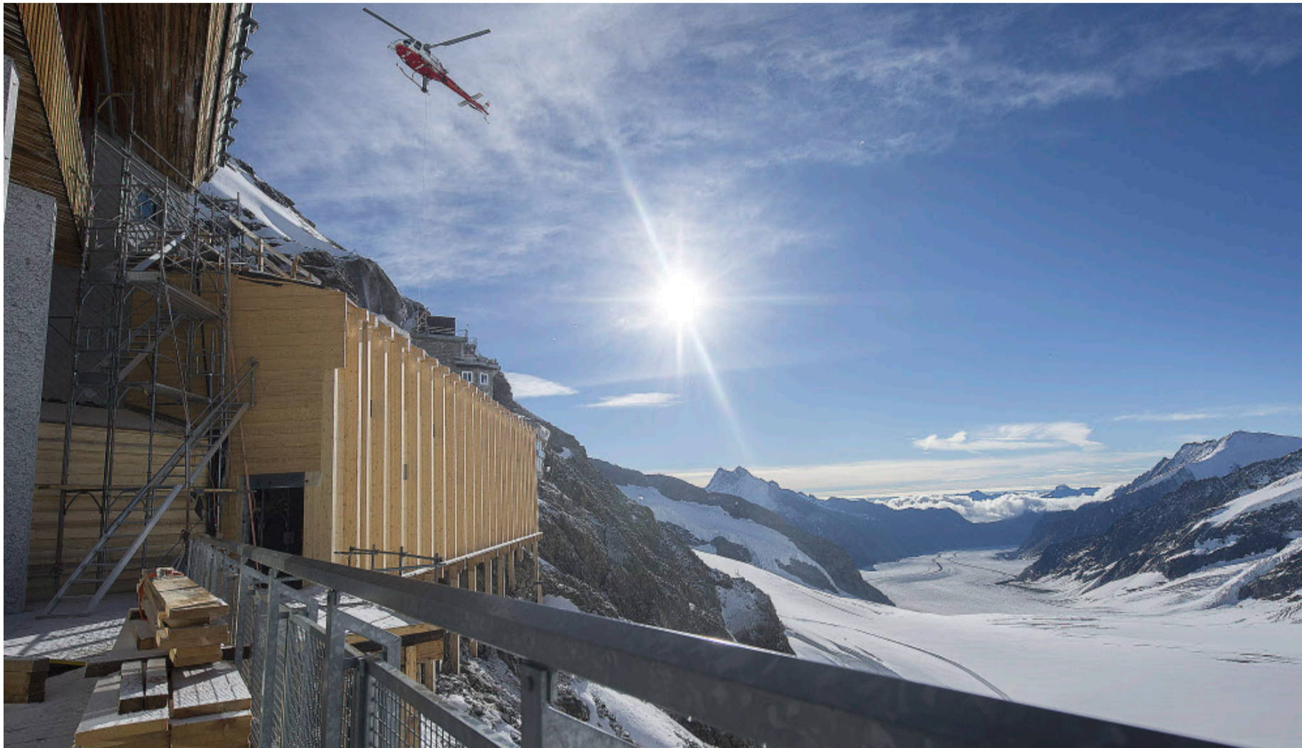
An die Aussenfassade des Gletscherrestaurants haben Zimmerleute ein Holzbiwak gebaut, das die Arbeiter im Winter vor Temperaturen von bis zu minus 30 Grad schützen wird.
